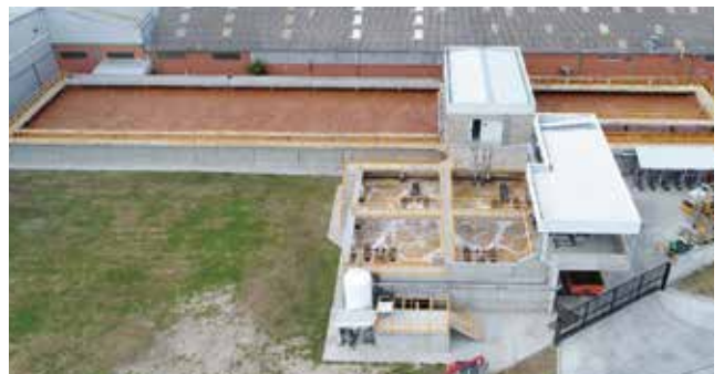
Planta de efluente con membranas MBR.
